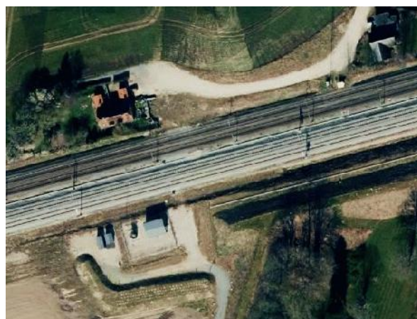
Bolig ses mod NV. Adamshøjvej Í Rg km 63,9 Ky km 56,6 Adamshøj neutralsektion km 57,5-58,0 Í kmskift (59,2)/61,4 Bjs (Bjæverskov) km 46,1 Kilde: http://map.krak.dk/ , Hybrid etc. °, Luftfoto 2018
